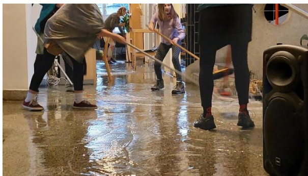
Havárie vodovodu ve škole - vytopení prvního nadzemního podlaží a suterénu
